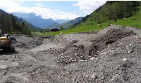
Die Baustelle und das Resultat unten
